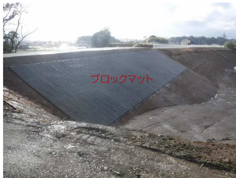
池上池 堤体改修写真
